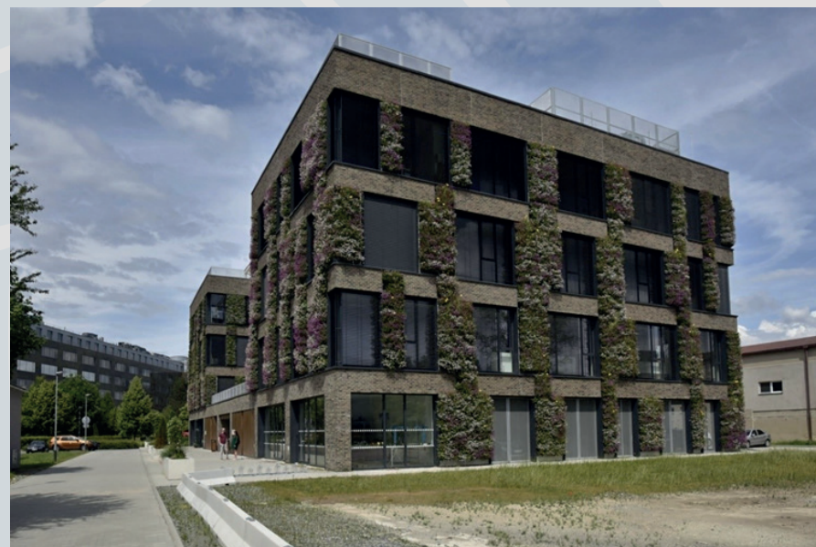
Budova Vědeckotechnického parku Envelopa Hub – zelená fasáda
